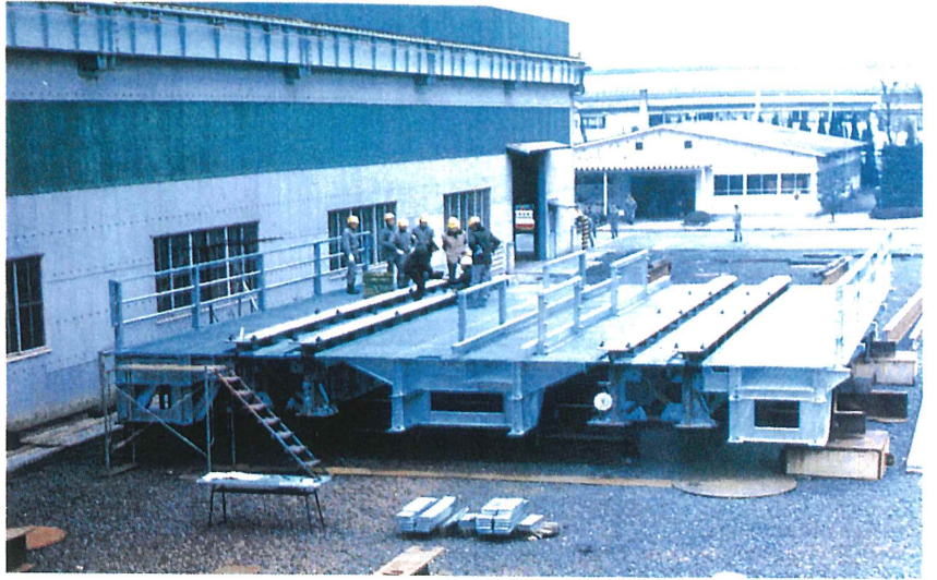
本四連絡橋管理路仮組
