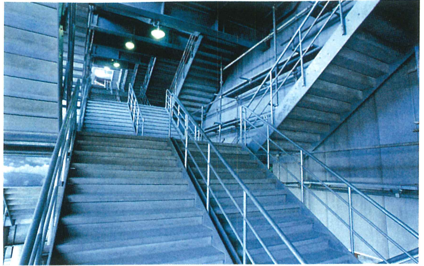
駅前大型デパート非常用階段
