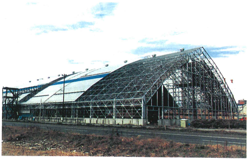
海岸近くに建てられた貯炭所上屋
