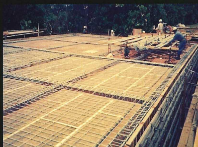
沖縄海洋博公園 マナティ館 基礎工事
