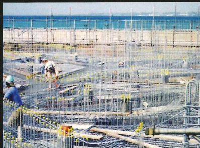
沖縄県栽培漁業センター 基礎工事
