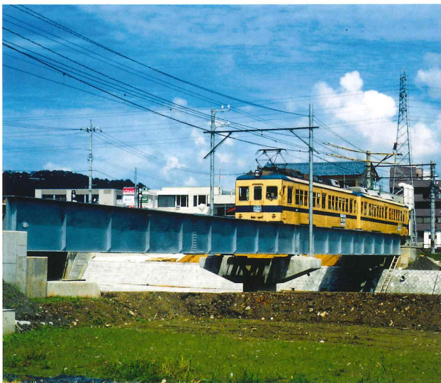
福井鉄道 江端場川橋
