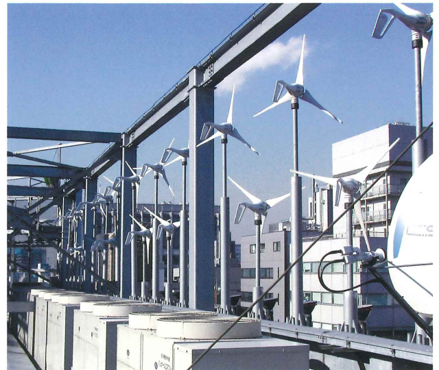
東京都永代橋エコピアザビル
