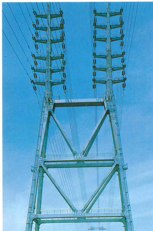
送電鉄塔 (ボックス鋼板)
