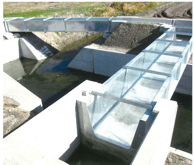
農業用水水路橋（掛樋）
