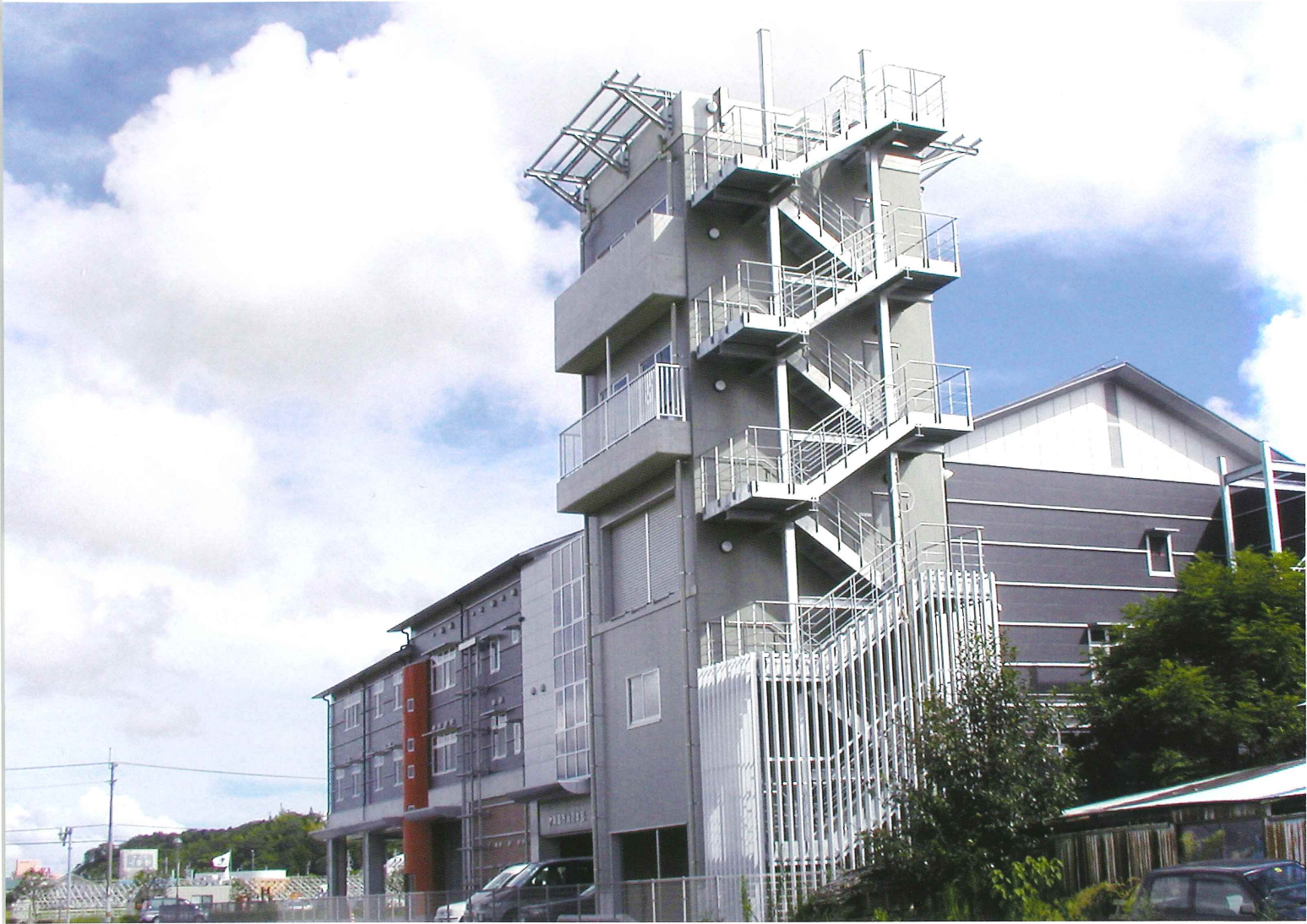
高知県南国市消防庁舎訓練塔
