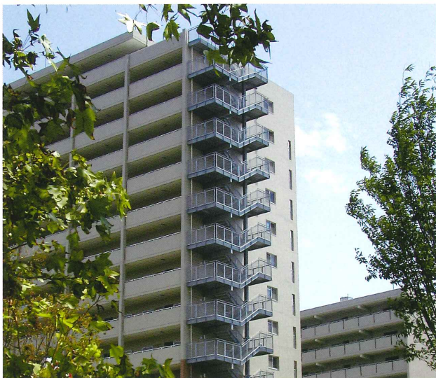
マンション外階段
