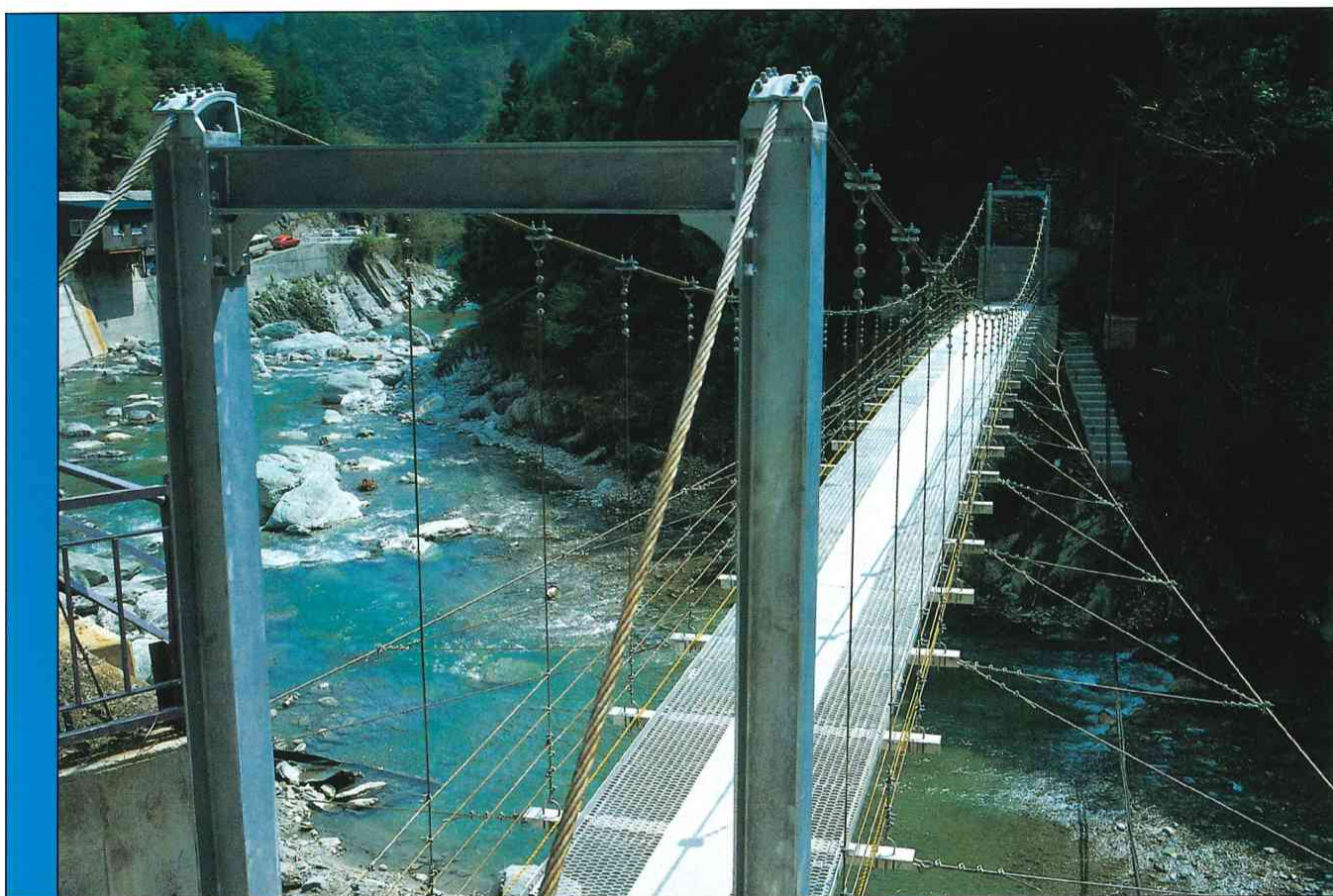
▲吉野川上流の溪谷に架設されたつり橋 支柱およびグレーチングに溶融亜鉛めっきが施されています。
