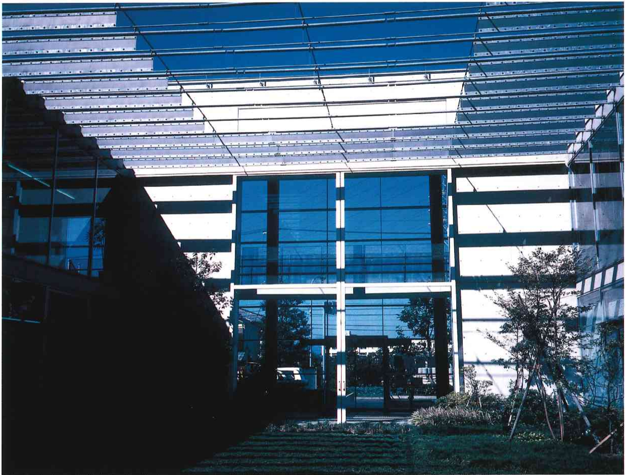
横浜市泉区下和泉地域ケアプラザ亜鉛めっき鋼製ルーバー
