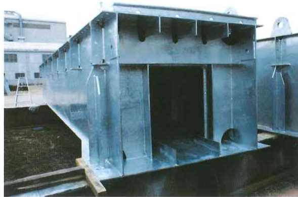
写真3 歩道橋用箱桁 中間ダイヤフラム下方縦リブには写真で示すように大きなスカラップがとられている。
