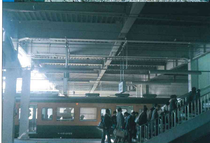
▲橋上駅（倉敷） 軌道をまたいで建てられた駅舎の鋼桁(200トン)は、メンテナンスフリーのため溶融亜鉛めっきされています。
