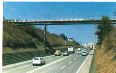
四方寄(よもぎ)跨道橋 [田園]
