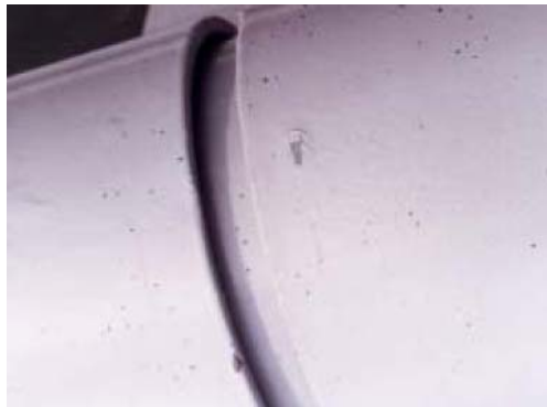
写真7 塗装面に発生したブリストア
