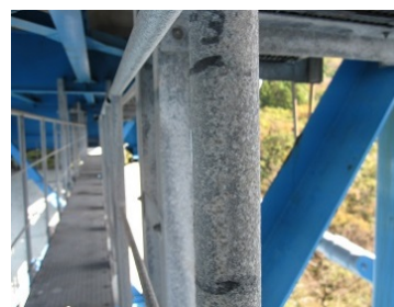
図3 検査路の外観
